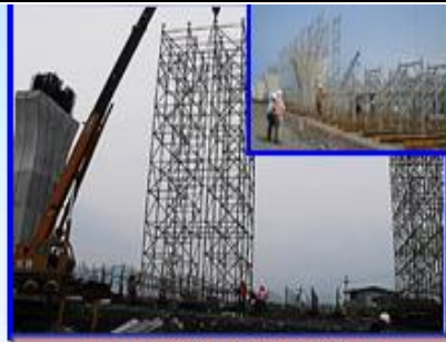
支撐架地面組立完成後吊裝
