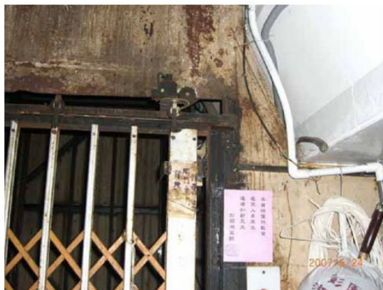
照片1：手拉門未緊閉，電氣連鎖裝置即可作用。 照片2：機械連鎖裝置未發揮作用。（車廂已於 2樓升至3樓）
