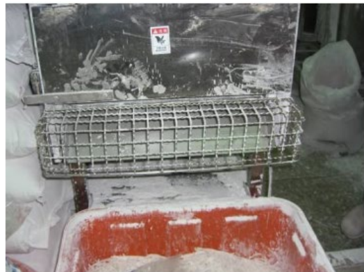
切斷機設備加裝防護網
