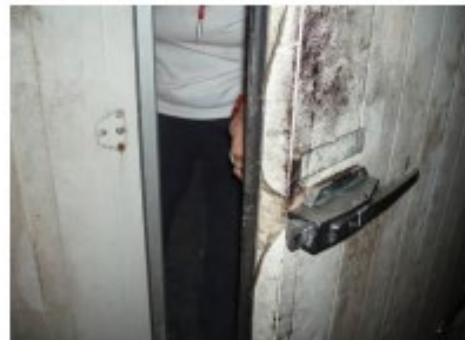
紅色三角旋鈕以手旋轉後即可拆除，冷凍庫出入口外部鎖扣即掉落到地上，即打開出入口之門
