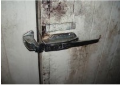
原料冷凍庫外部鎖扣
