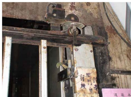
照片1：手拉門未緊閉，電氣連鎖裝置即可作用。 照片2：機械連鎖裝置未發揮作用。（車廂已於 2樓升至3樓）
